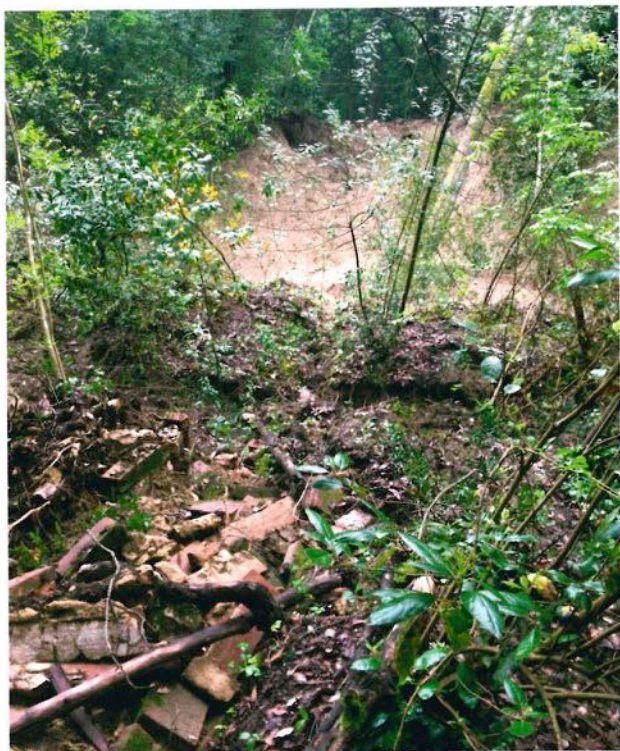
Fig. 16 - Parte della collina che ha ceduto nel gennaio del 2013, la frana è andata ad ostruire la strada che porta alla Villa poco prima del viale delle sequoie. In primo piano dei grossi mattoni che, in origine, formavano il sistema di drenaggio delle acque (Foto Matilde d'Oriano, 2013)
